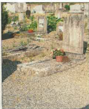
Le carré A qui va être réhabilité. Le DL/J.N.
