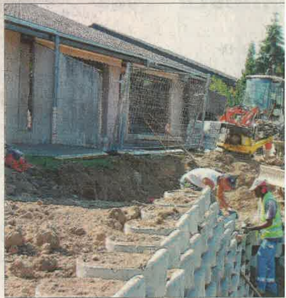
Réalisation d'un bassin paysagé avec poches de rétention des eaux pluviales devant l'école maternelle.
