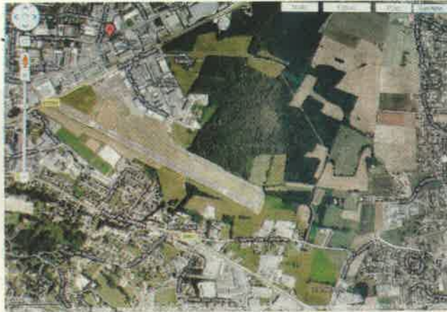
Les terrains concernés par le projet du nouveau PEB se situent dans le prolongement des pistes de l'aéroport d'Annemasse.
