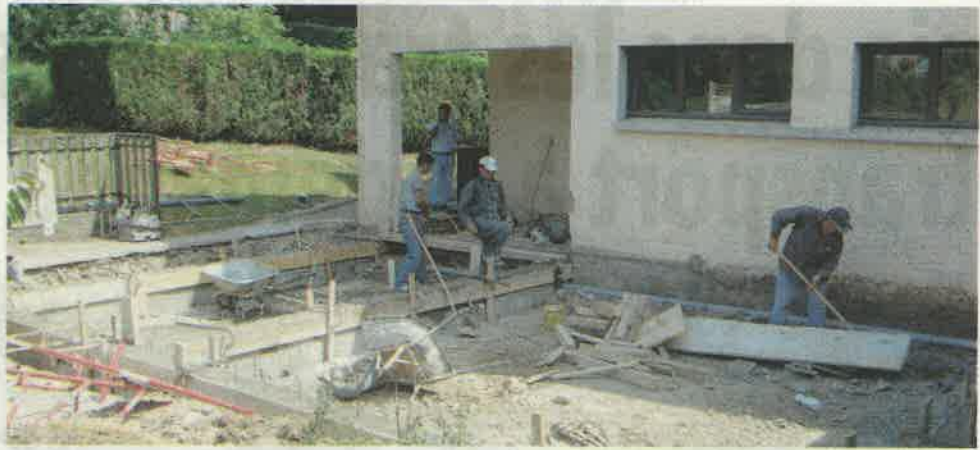
Débutés en juillet, les travaux d'extension du restaurant du groupe scolaire Frison-Roche devraient durer jusqu'au mois de janvier 2011.
