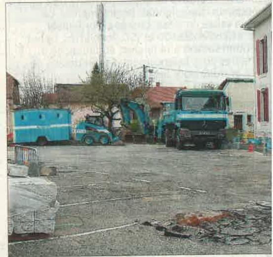
L.B. Les pelleteuses ont commencé les travaux extérieurs. Le DL/L.B.
