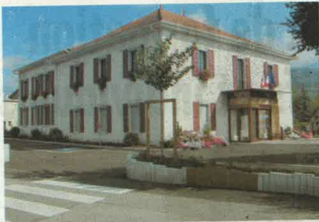
Une vue des aménagements extérieurs de la mairie portant sur le nouveau sas d'entrée et les façades du bâtiment.
