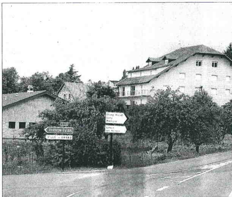
La Maison familiale rurale de Cranves-Sales entreprend d'importants travaux pour être remise aux normes. Elle accueille 226 élèves dans l'ancienne colonie de vacances Champ Molliaz. LE D.L.L.D.
